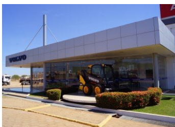
Entrepasto Máquinas, distribuidor CE
